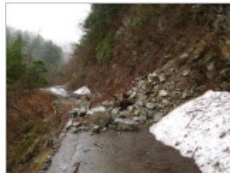
崖崩れ個所もあり
