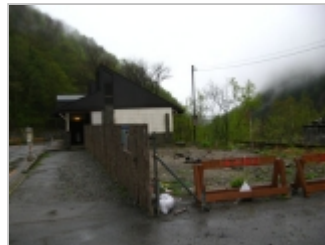
無料温泉施設は解体されていた
